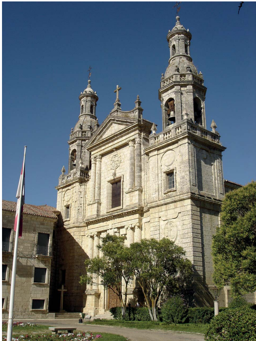
Fachada barroca del monasterio de la Santa Espina (Valladolid)
