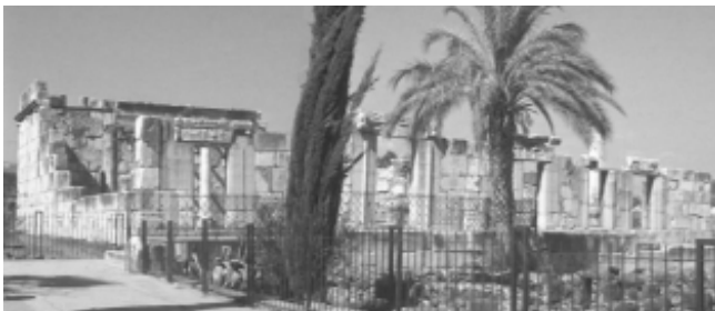
Restos de una sinagoga del siglo III en Cafarnaúm. Esta sinagoga se edificó sobre los restos de la antigua, del tiempo de Jesús.
